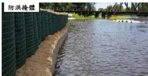
圖5 運河運用掩體設置防洪屏障圖
